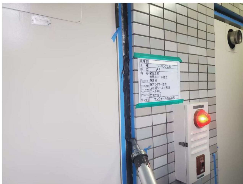
シーリング工事
