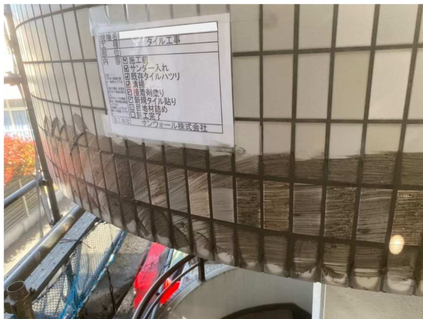
外壁補修工事
