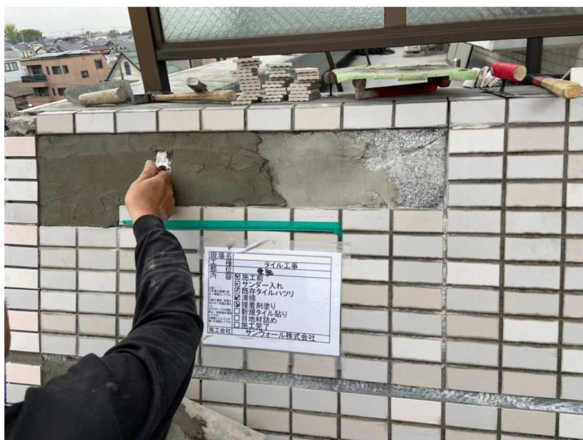
外壁補修工事
