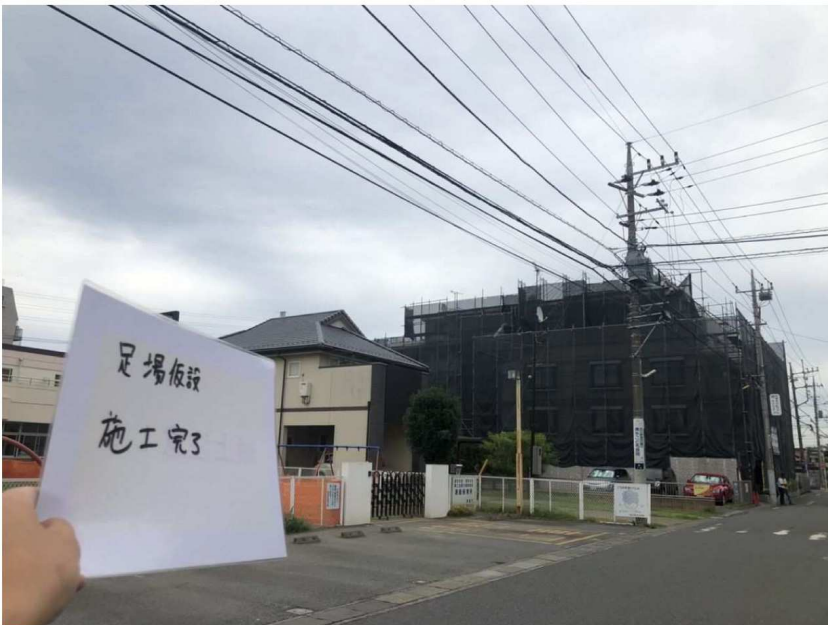
足場仮設工事
