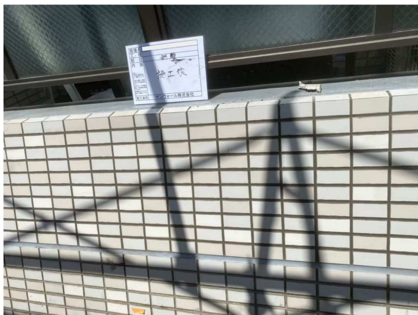
外壁補修工事
