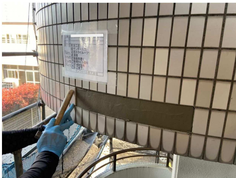
外壁補修工事
