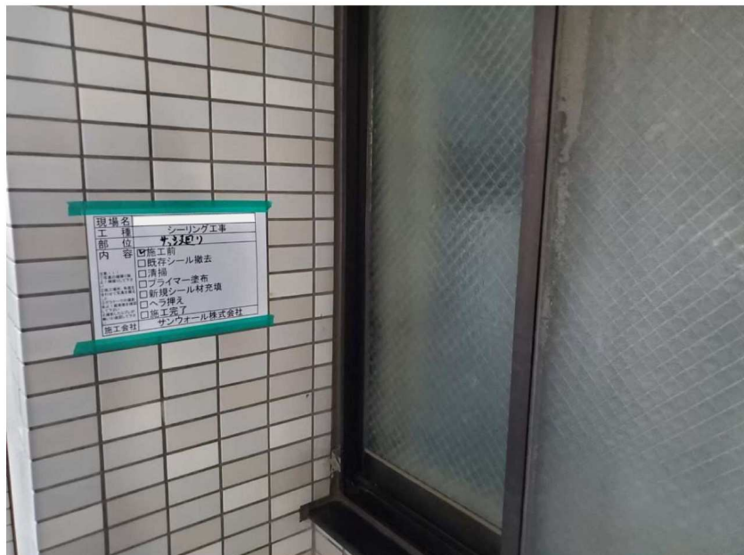
シーリング工事
