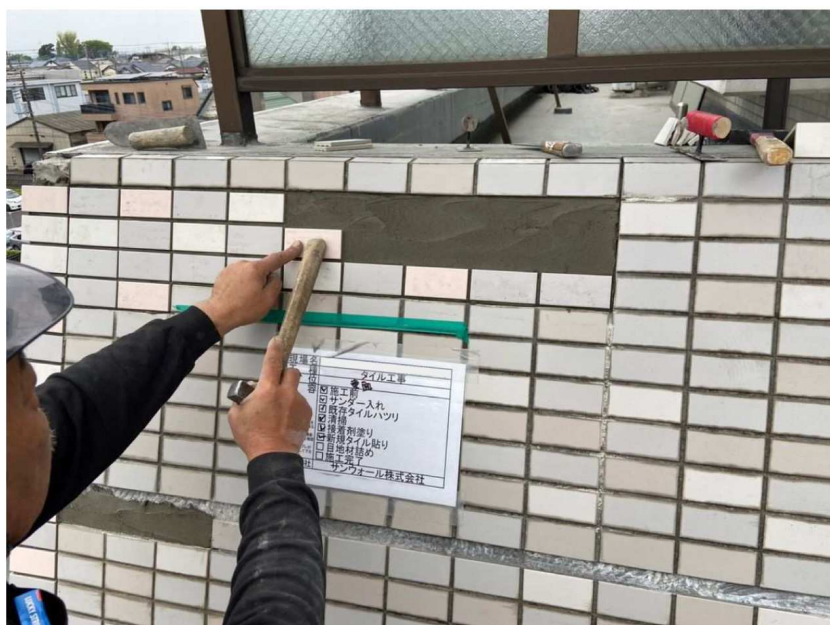
外壁補修工事
