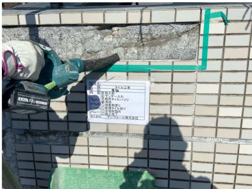
外壁補修工事
