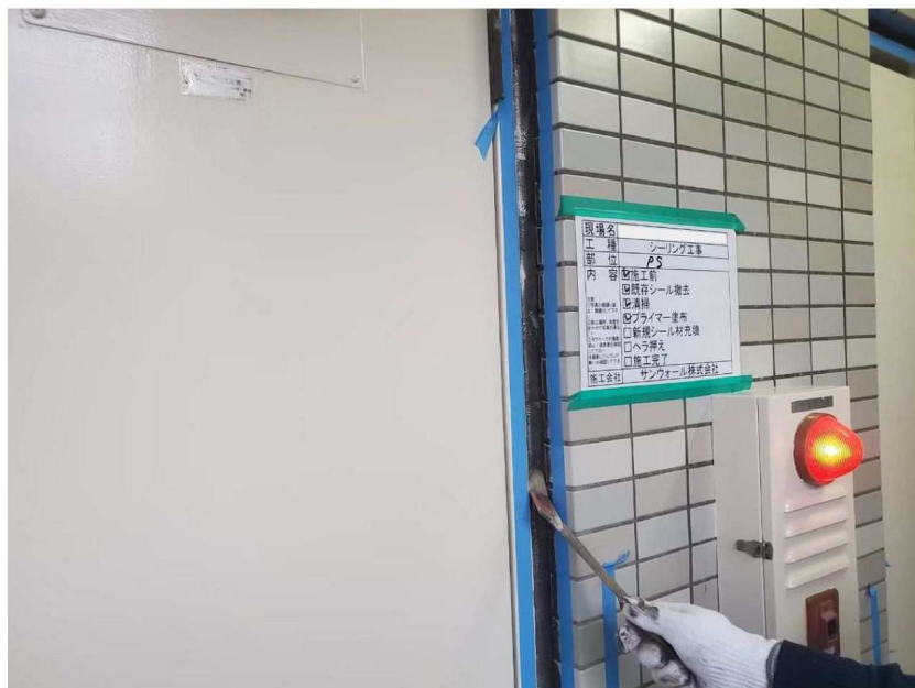
シーリング工事
