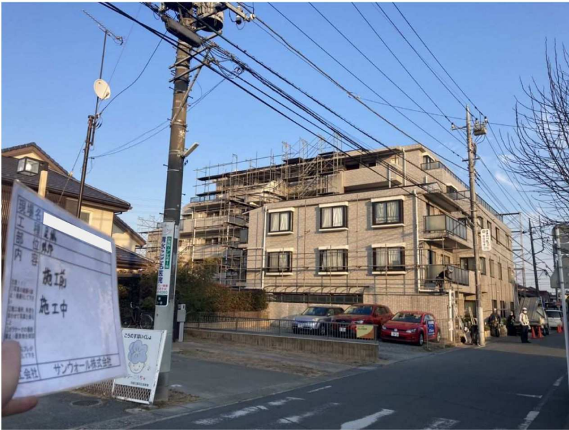
足場仮設工事
