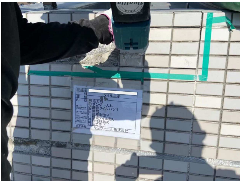
外壁補修工事
