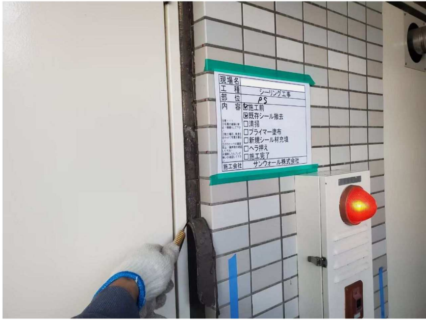
シーリング工事
