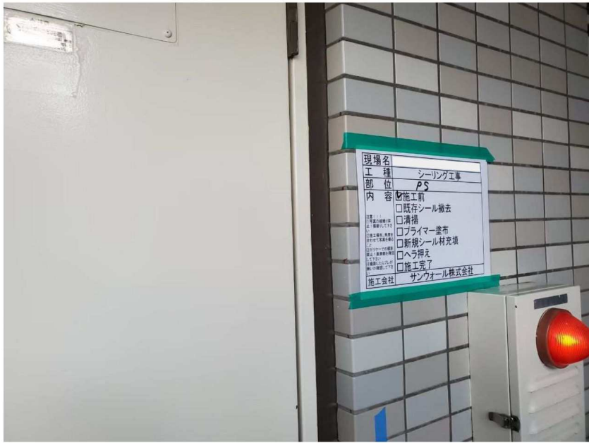
シーリング工事
