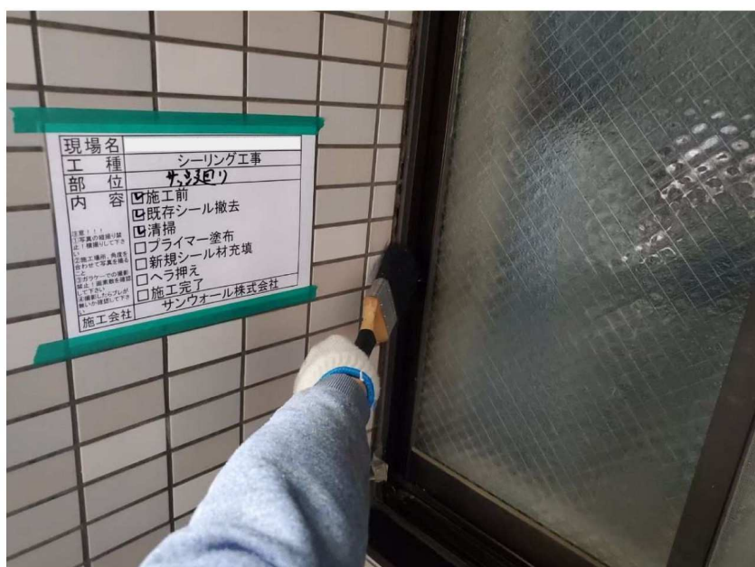
シーリング工事
