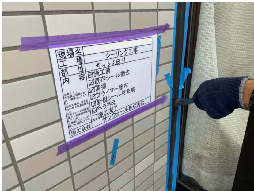
シーリング工事
