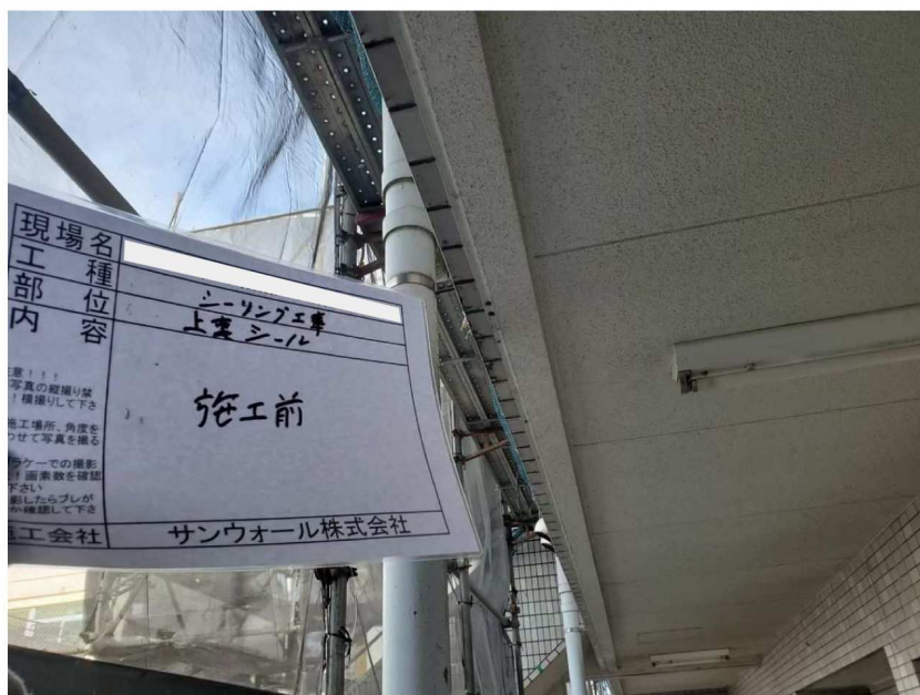
シーリング工事
