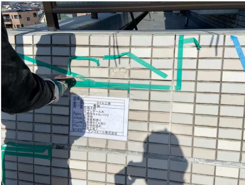
外壁補修工事
