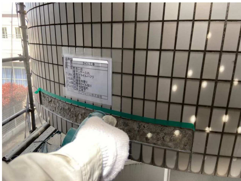
外壁補修工事
