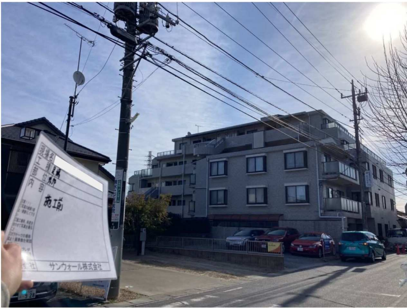
足場仮設工事
