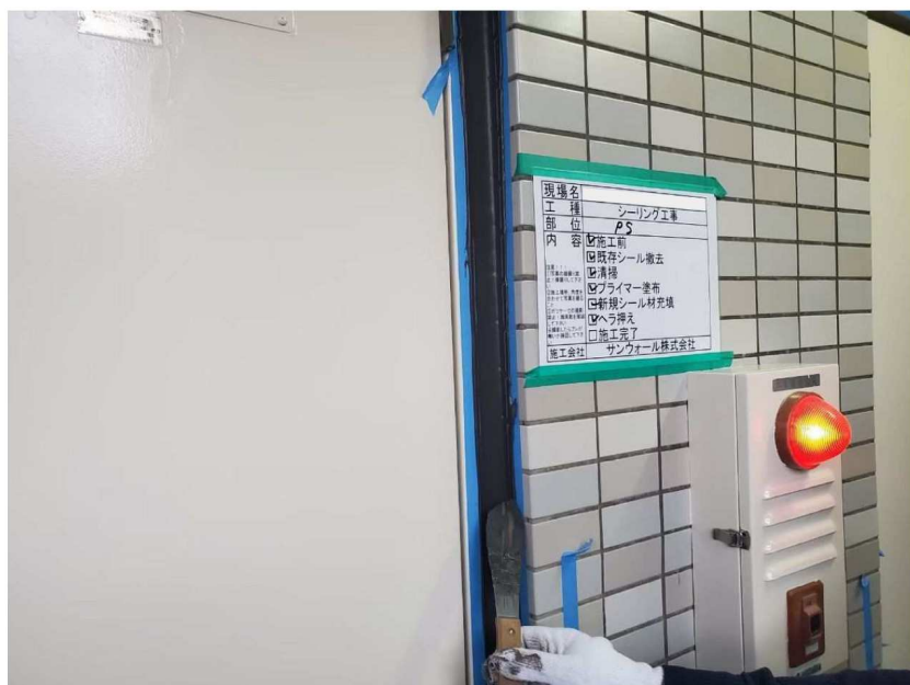
シーリング工事
