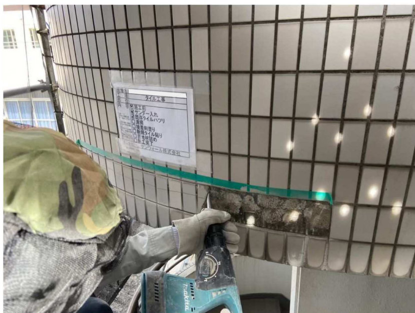
外壁補修工事
