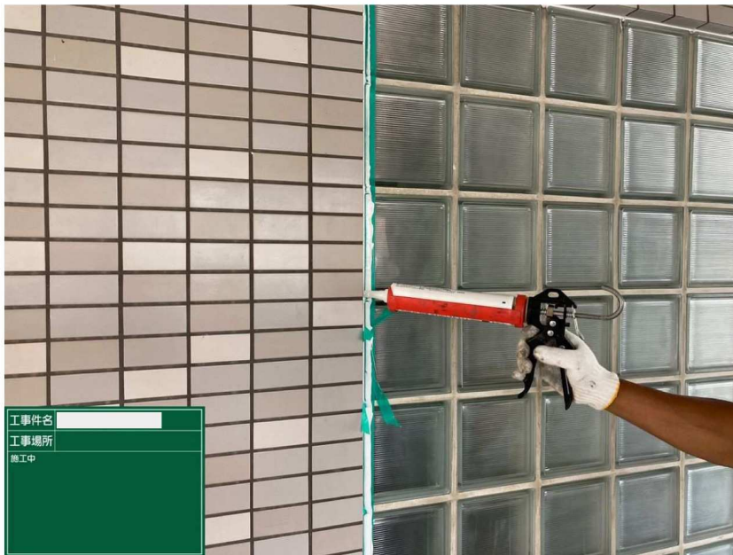
シーリング工事
