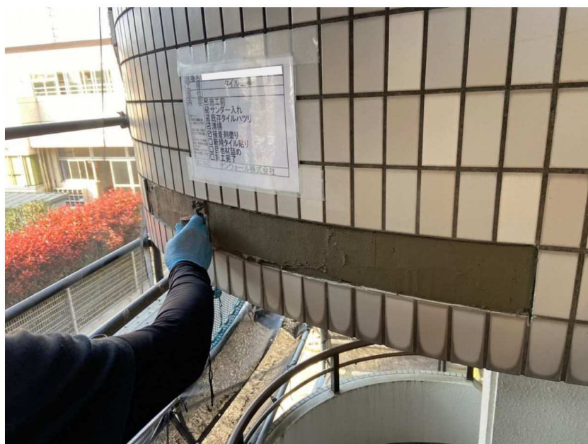
外壁補修工事
