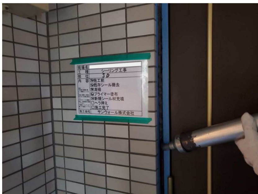
シーリング工事
