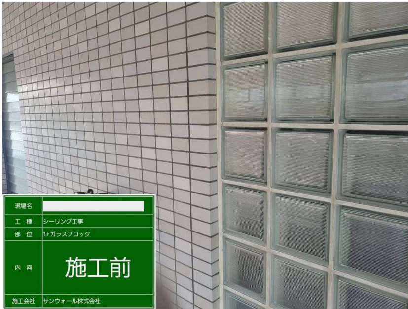
シーリング工事
