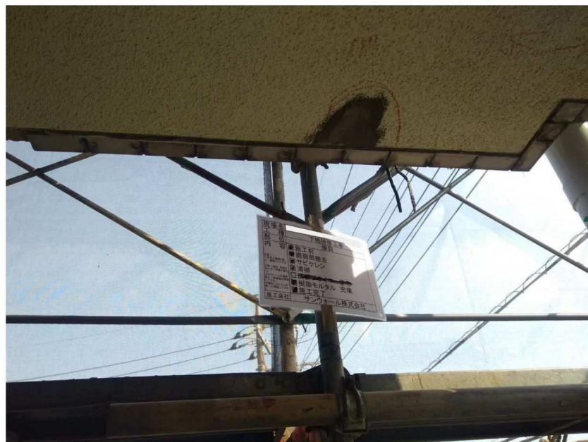
下地補修工事
