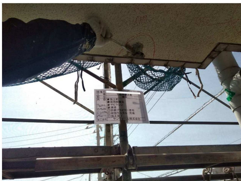
下地補修工事
