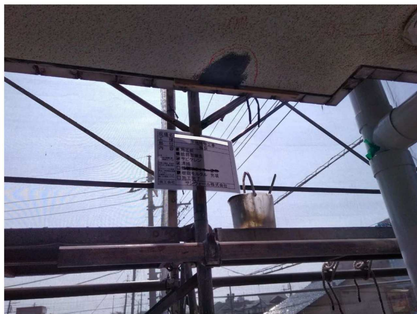
下地補修工事
