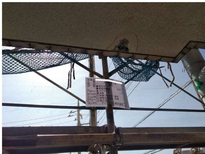
下地補修工事
