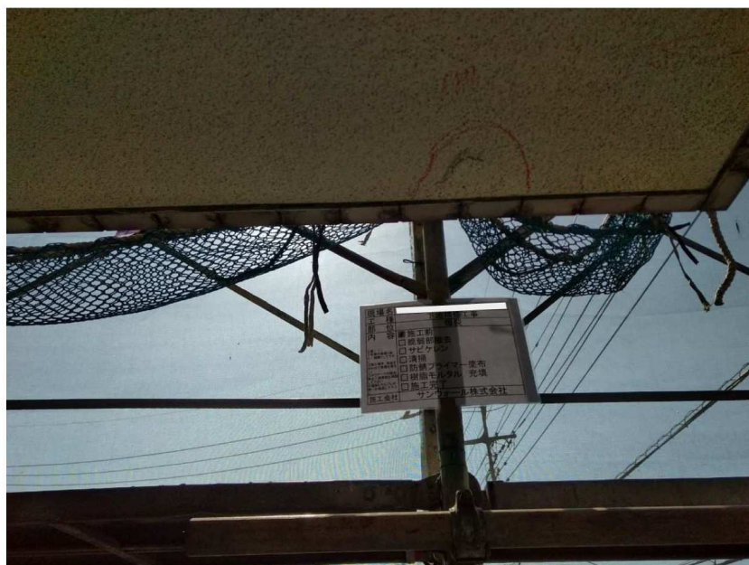
下地補修工事
