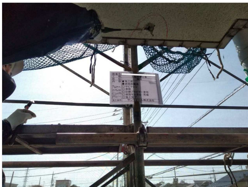
下地補修工事
