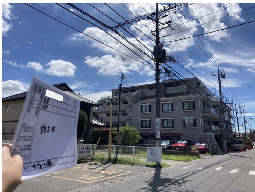
足場解体工事
