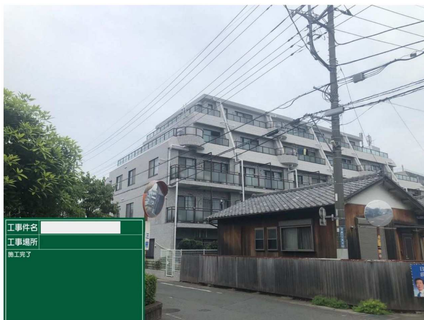
足場解体工事
