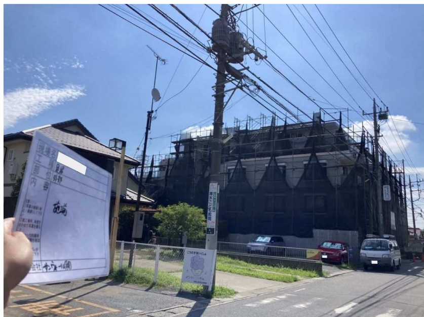
足場解体工事
