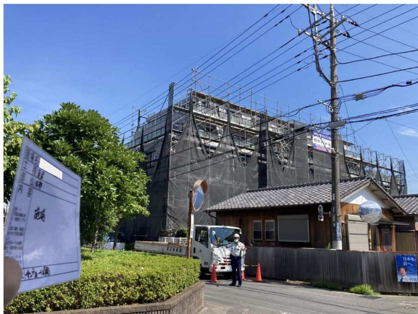
足場解体工事
