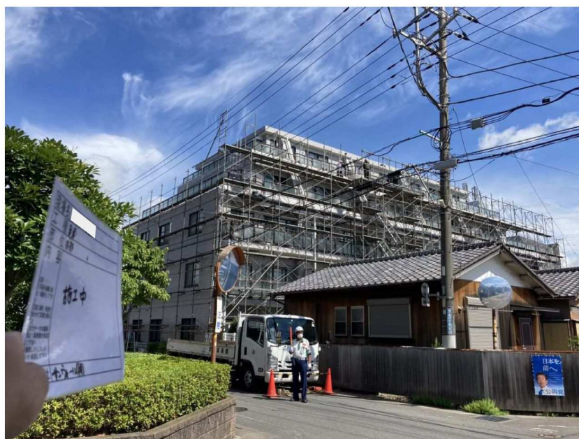
足場解体工事
