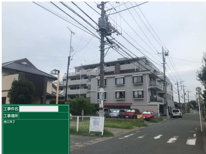
足場解体工事
